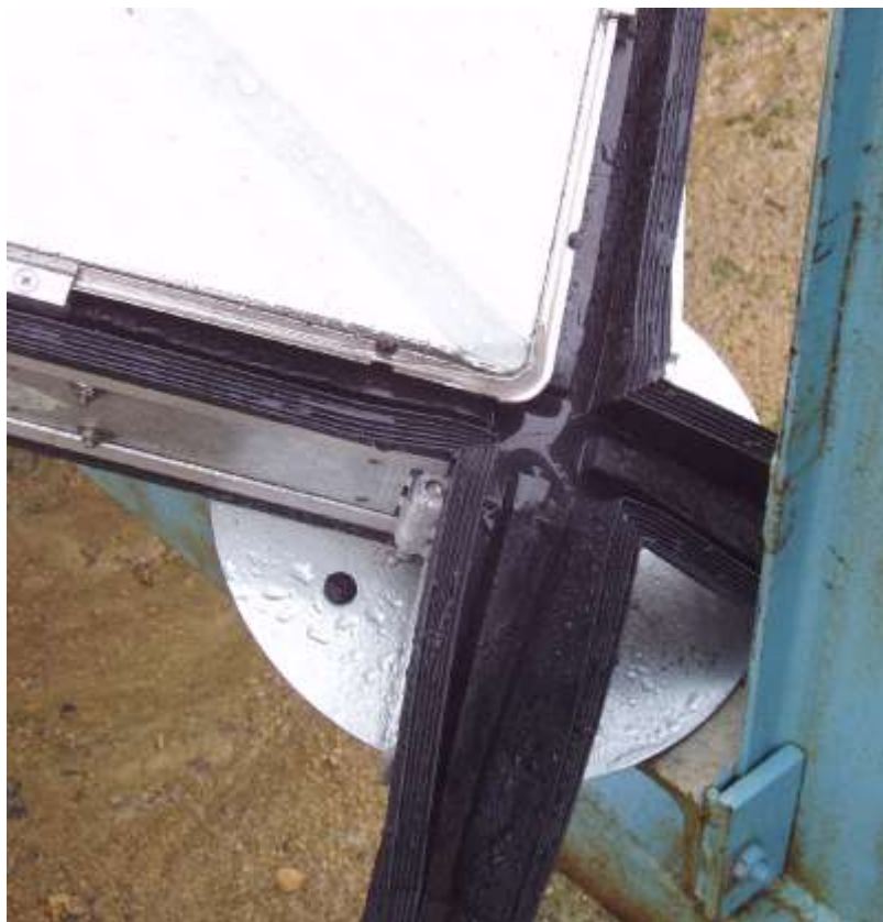
Figuur 17: Het roestvast stalen buitenpaneel is geïsoleerd van het gegalvaniseerd binnen paneel door middel van dichtingen.
