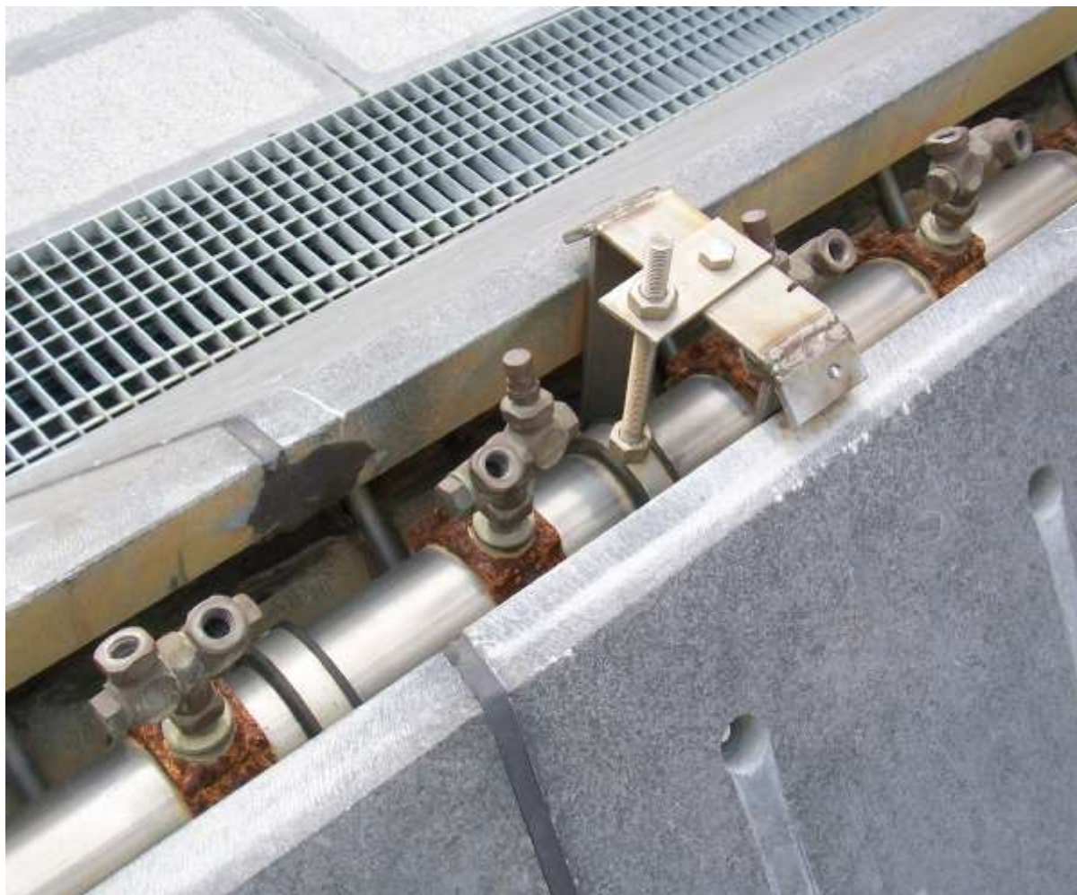
Figuur 15: Corrosie van galvanisch verzinkte buisklemmen in onmiddellijk contact met roestvast staal en messing
