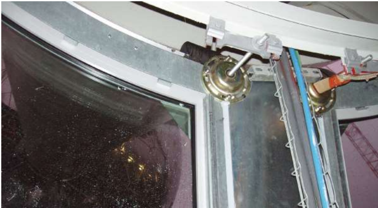
Figuur 19: Om galvanische corrosie te voorkomen is de roestvast stalen plaat bevestigd aan de stalen binnenstructuur in droge ruimtes.
