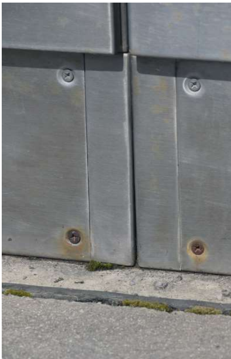
Figuur 14: Hoe kleiner het verzinkte oppervlak t.a.v. van het roestvast stalen oppervlak, hoe sterker de galvanische reactie.
