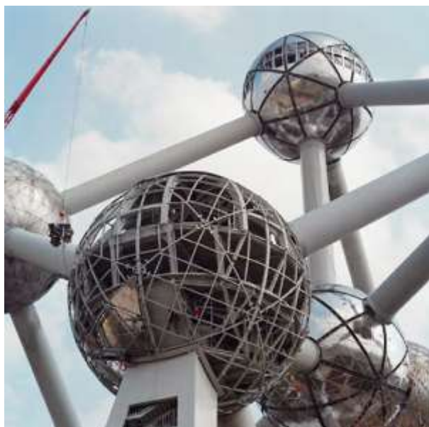
Figuur 16: Bevestiging van roestvast stalen buiten panelen op een koolstofstalen structuur aan het Atomium, Brussel.
