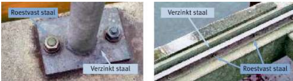
Figuur 8a, 8b: Praktische toepassingen van de principes getoond in Figuur 6: gegalvaniseerd staal in contact met roestvast staal in een kust omgeving.
