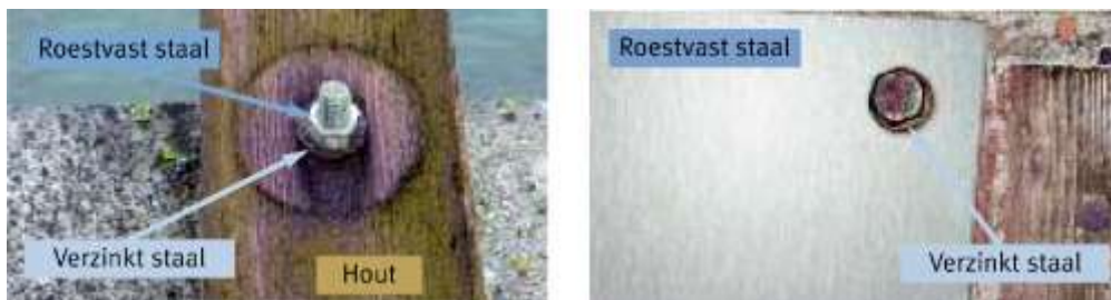
Figuur 10a, 10b: Praktische voorbeelden van het principe getoond in Figuur 9 (verzinkt staal in contact met roestvast staal, in een zee atmosfeer).
