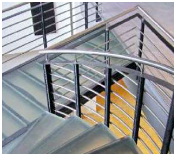
Figuur 5: Omdat er geen elektrolyten zijn in normaal verwarmde en geventileerde binnen toepassingen, zal de combinatie van roestvast staal met andere metalen, zoals geschilderd koolstofstaal normaliter geen risico geven op galvanische corrosie in dergelijke omstandigheden.
