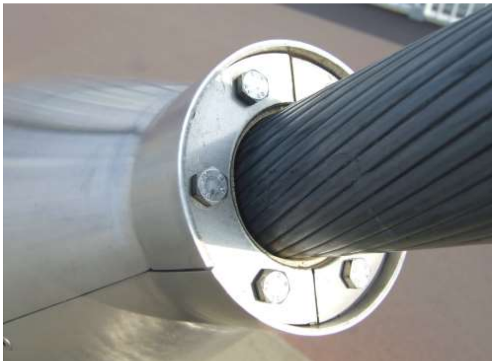
Figuur 26: Er zal geen galvanische corrosie optreden tussen de verschillende types roestvast staal, zelfs als ze niet dezelfde corrosieweerstand hebben.
